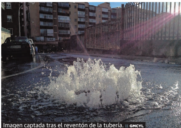
Imagen captada tras el reventón de la tubería. :: GMCYL
